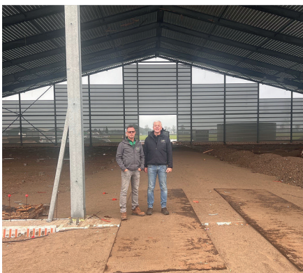
Edward en Evert Bot in hun nieuwe hal dat onder Breeam wordt uitgevoerd
