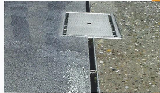
Spleetgoot voert effectief proceswater af. De vloercoating (links) waarborgt een slijtvaste hygiënische vloer.
